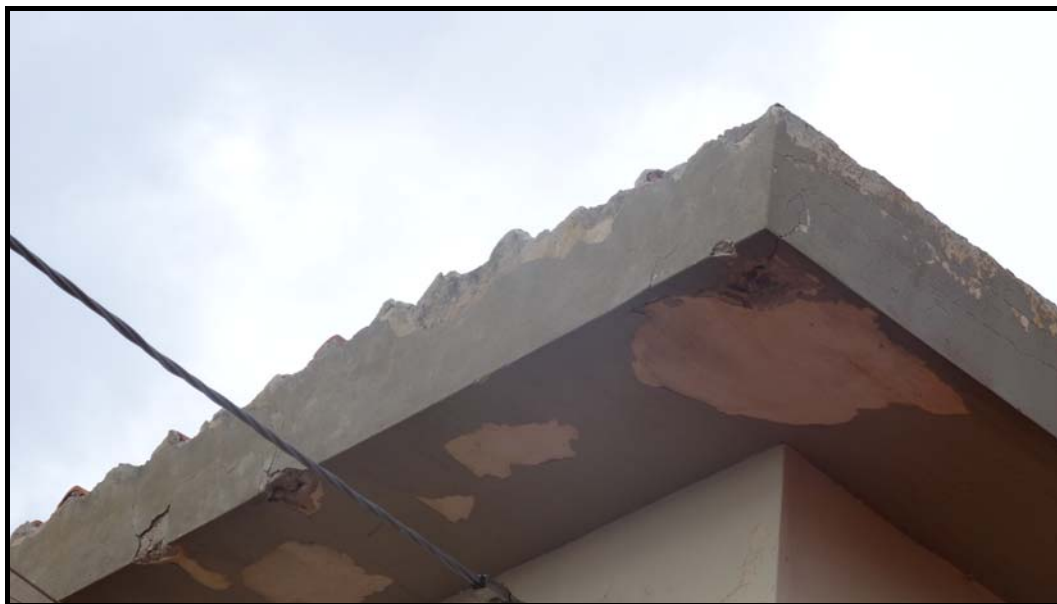
Foto 3: Particolare stato di degrado cornicione.
