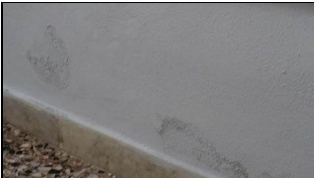
Foto 8: Particolare stato degrado dell'intonaco.
